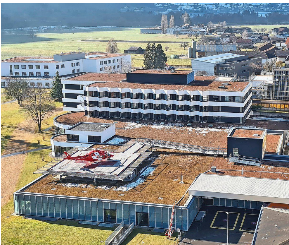
Das Spital Interlaken ist noch nicht fertiggebaut. Als letzte Etappe soll das Haus E (rechts im Bild) abgerissen und ersetzt werden. Fotos: Bruno Petroni
